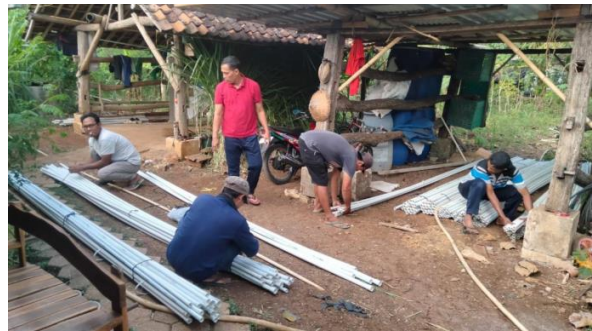
Gambar 2. Persiapan instalasi irigasi sprinkle
