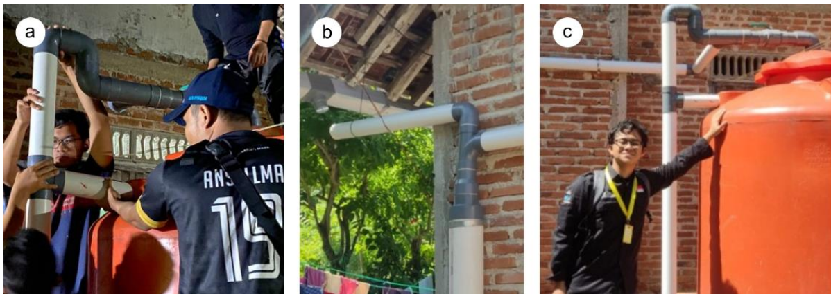
Gambar 4. Proses instalasi IPAHA pada Dusun Godeg Wetan: (a) Proses instalasi; (b) Pemasangan pada kanopi; (c) Hasil akhir instalasi
