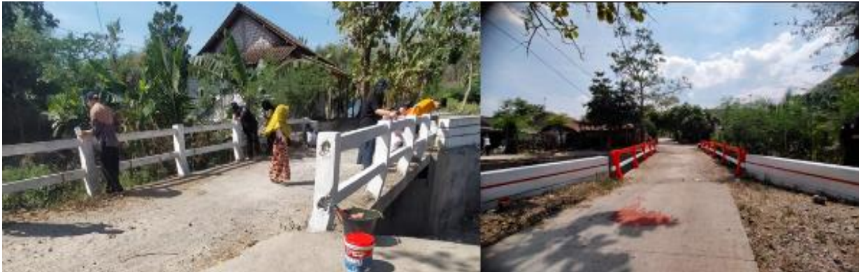
Gambar 16. Kegiatan pengecatan jembatan oleh mahasiswa KKN Jembatan desa Sidowayah
