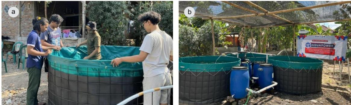
**Gambar 5.** Konstruksi kolam RAS Program AquaPower di Desa Sumberharjo: (a) Konstruksi rangka kolam dan pemasangan terpal kolam; (b) Kolam RAS yang telah selesai dikonstruksi
