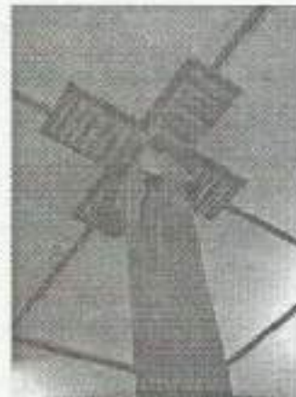
Gambar 5. Tiang penyangga yang dipasang kain agar rumah tidak roboh ketika terjadi peristiwa gempabumi
