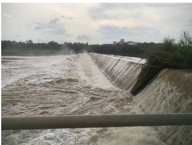
(a) Srandakan check dam
