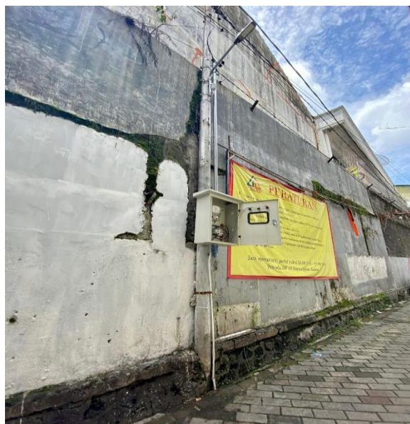
Gambar 4. Penerangan Jalan Umum (PJU) di Kampung Sosrowijayan Kulon
