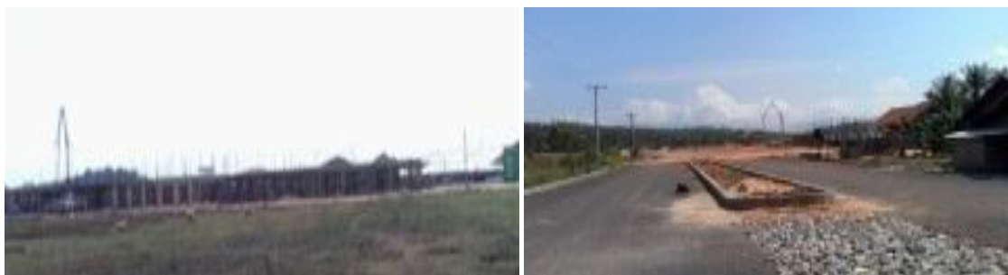
Gambar 5. Komplek Pembangunan RSUD Kab. Pringsewu
