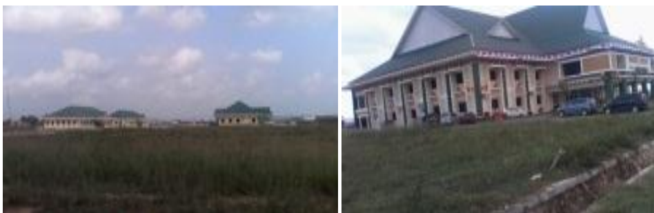
Gambar 4. Komplek Perkantoran PEMDA Kabupaten Pringsewu
