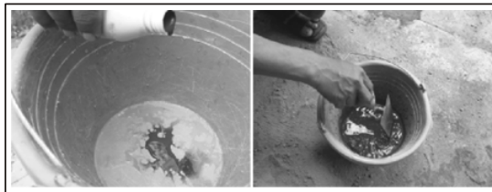
Gambar 5. Proses pewarnaan beton
