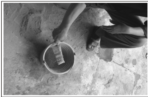
Gambar 4. Proses pembuatan campuran beton
