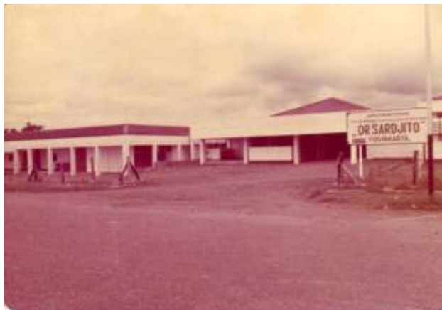
Gambar 4. Gedung RS. Dr. Sardjito Tahun 1974 Sumber: Khazanah Arsip Statis Arsip UGM Nomor AF1/IP.IG/1974-20A
