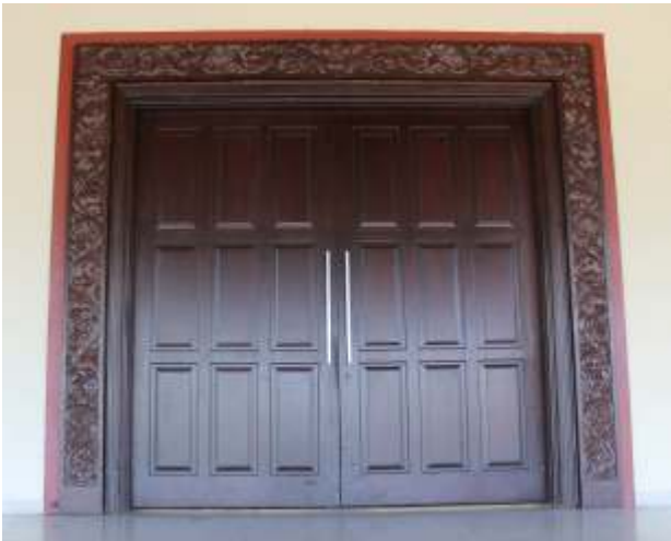
Foto 5 Foto Ukiran Pintu Lantai 2 Gedung Auditorium UGM Fotografer: Heri Santosa
