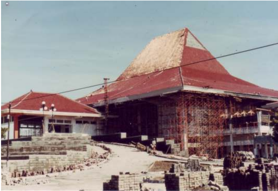
Foto 1 Gedung GSP yang belum jadi tampak dari depan sebelah kiri (Sumber: AF3.IP.IG.1994.1G)
