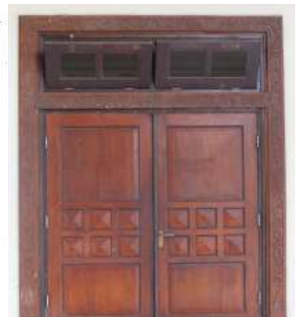
Foto 4 Foto Ukiran Pintu lantai 1 Gedung Auditorium UGM Fotografer: Heri Santosa
