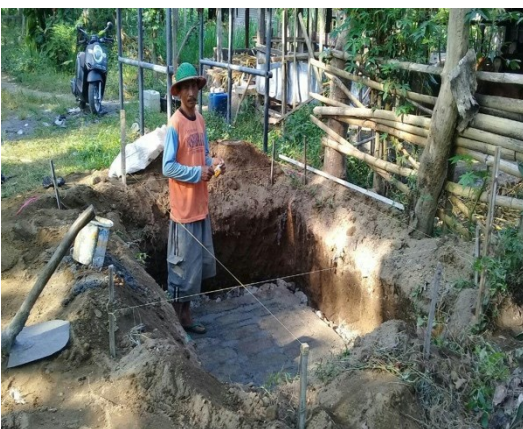
Gambar 7. Pembangunan bak sumber air
