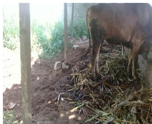
Gambar 3. Kondisi lantai kandang sebelum diperbaiki
