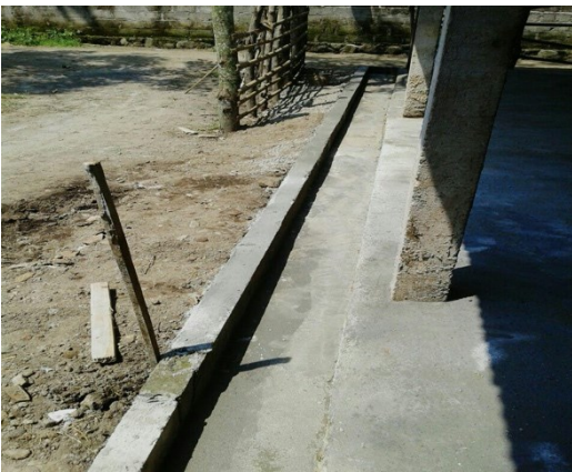
Gambar 6. Perbaikan saluran limbah
