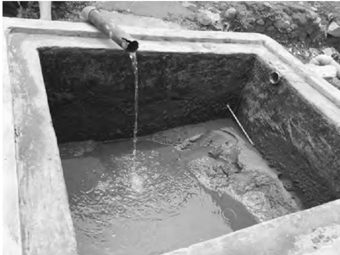
Gambar 2 Kotoran Berupa Lumpur yang Terendapkan di Dasar Bak Sedimentasi
