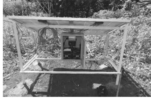
Gambar 9b Tampilan PLTS Kapasitas 200 W di Dekat Menara Kincir Angin
