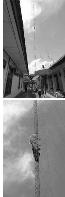
Gambar 7b Pemasangan Perangkat Rocket M5 Dilengkapi Antena Rocket Dish 5,8 Ghz
