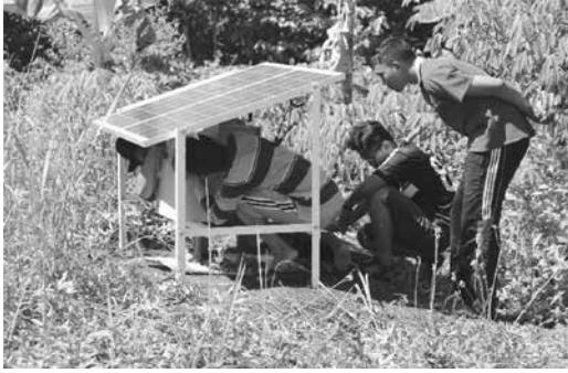
Gambar 9a Pembangunan PLTS dengan Bantuan Mahasiswa KKN UGM dan Warga
