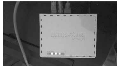
Gambar 8b Pemasangan Perangkat di Kantor Petinggi Nyamuk
