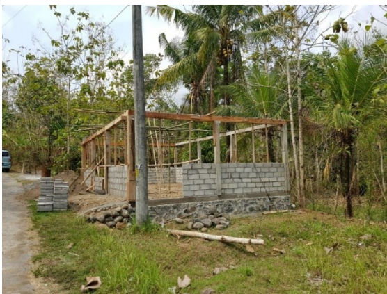
a. Capaian fisik pondasi bangunan
