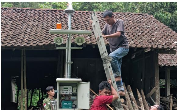
**Gambar 8.** Pemasangan *Rain Gauge* dan Sirine
