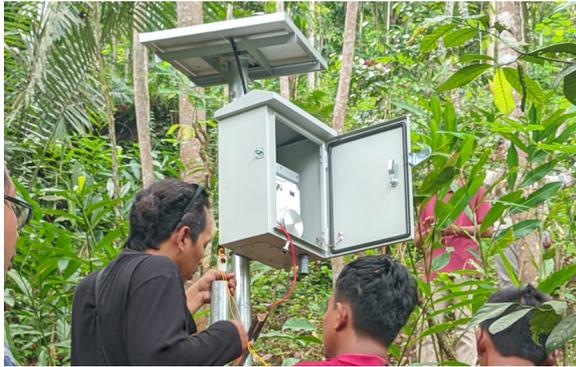
**Gambar 7.** Pemasangan Ekstensometer
