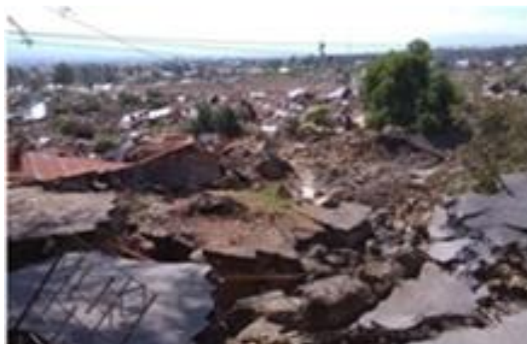
Gambar 3.3 Liquifaksi di pemukiman Perumnas di Matonda Balaroa (koordinat lokasi 0.909 LS, 119.839 BT).
